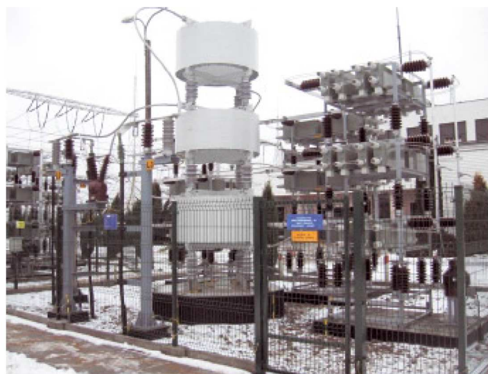
▶ Rys. 5. Bateria kondensatorowa 50 Mvar/30 kV z szeregowym dławikiem odstrajającym p = 7\% , SE Gdańsk Błonie
