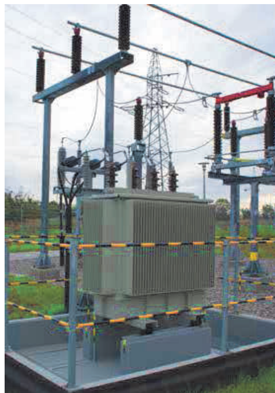
Fot. 1. Widok stanowiska dławik kompensacyjny 30 kV z zabudowaną misą.
