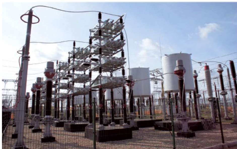
◀ Rys. 5. Rozwiązanie konstrukcyjne baterii kondensatorów 220 kV
