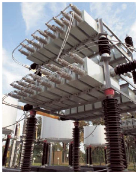
▲ Rys. 6. Układ połączeń kondensatorów na stanowiskach 220 kV
