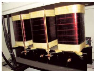
◀ Dławik o mocy 140 kvar, zainstalowany w baterii BDA 280/20
