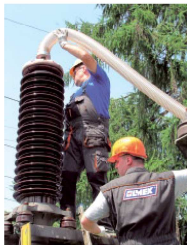
▲ Pomiary diagnostyczne linii kablowej 110 kV
