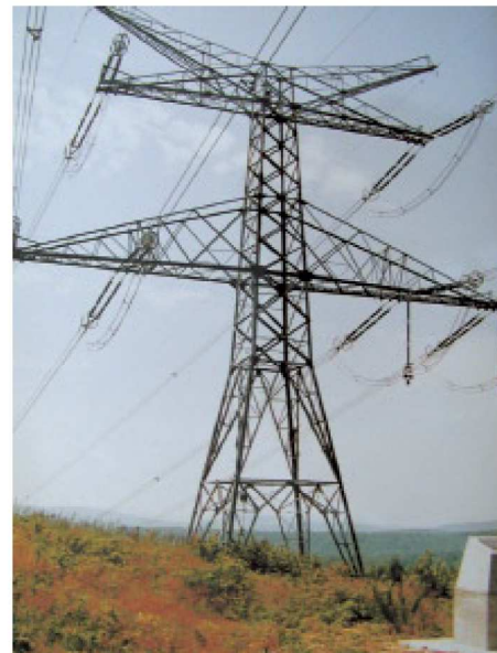
Linie napowietrzne wysokiego napięcia na bazie konwencjonalnych konstrukcji
