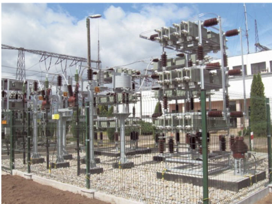
Regulowany układ kompensacji mocy biernej SN (20 kV)
