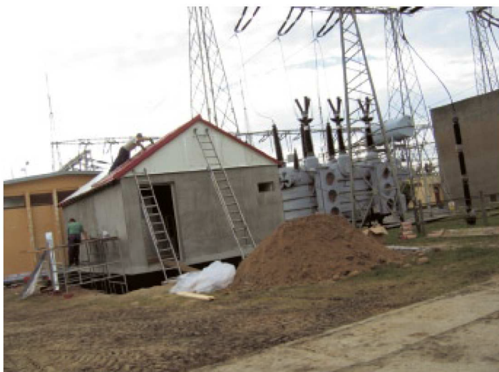
Budowa układów kompensacyjnych na stacji energetycznej 110/220/400 kV
